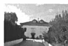
85 Casa do Crato Crato 7D; 1 Tw; P; PV
